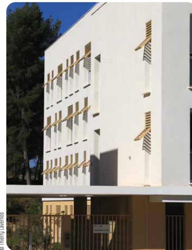
Résidence et pension de famille "Le Peymian" à La Ciotat (13) - 104-25 logements | Architecte : MAP Architectes
