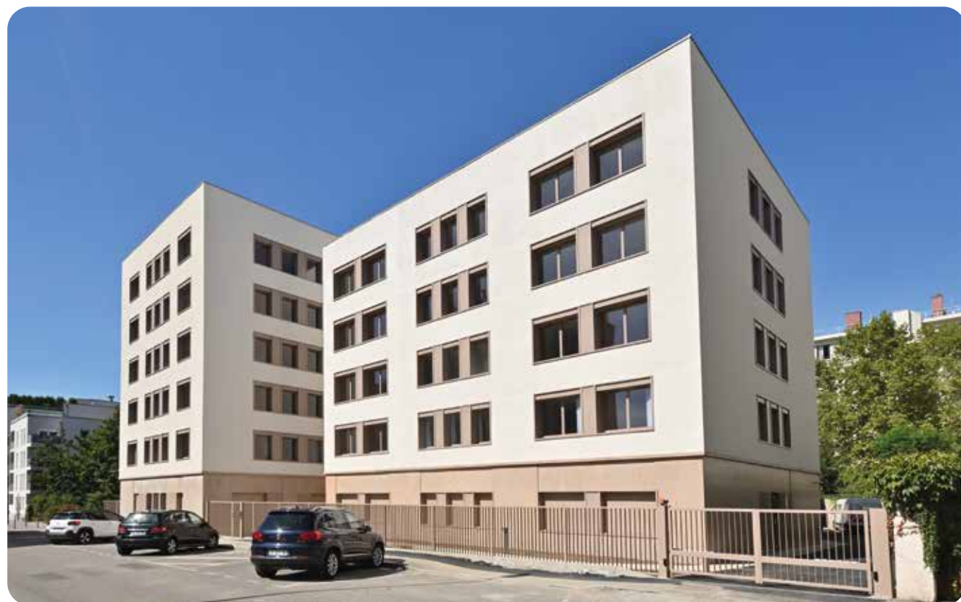
Résidence "Benoît Bernard" à Lyon (69) - 112 logements | Architecte : BAMAA Architectes Associés
