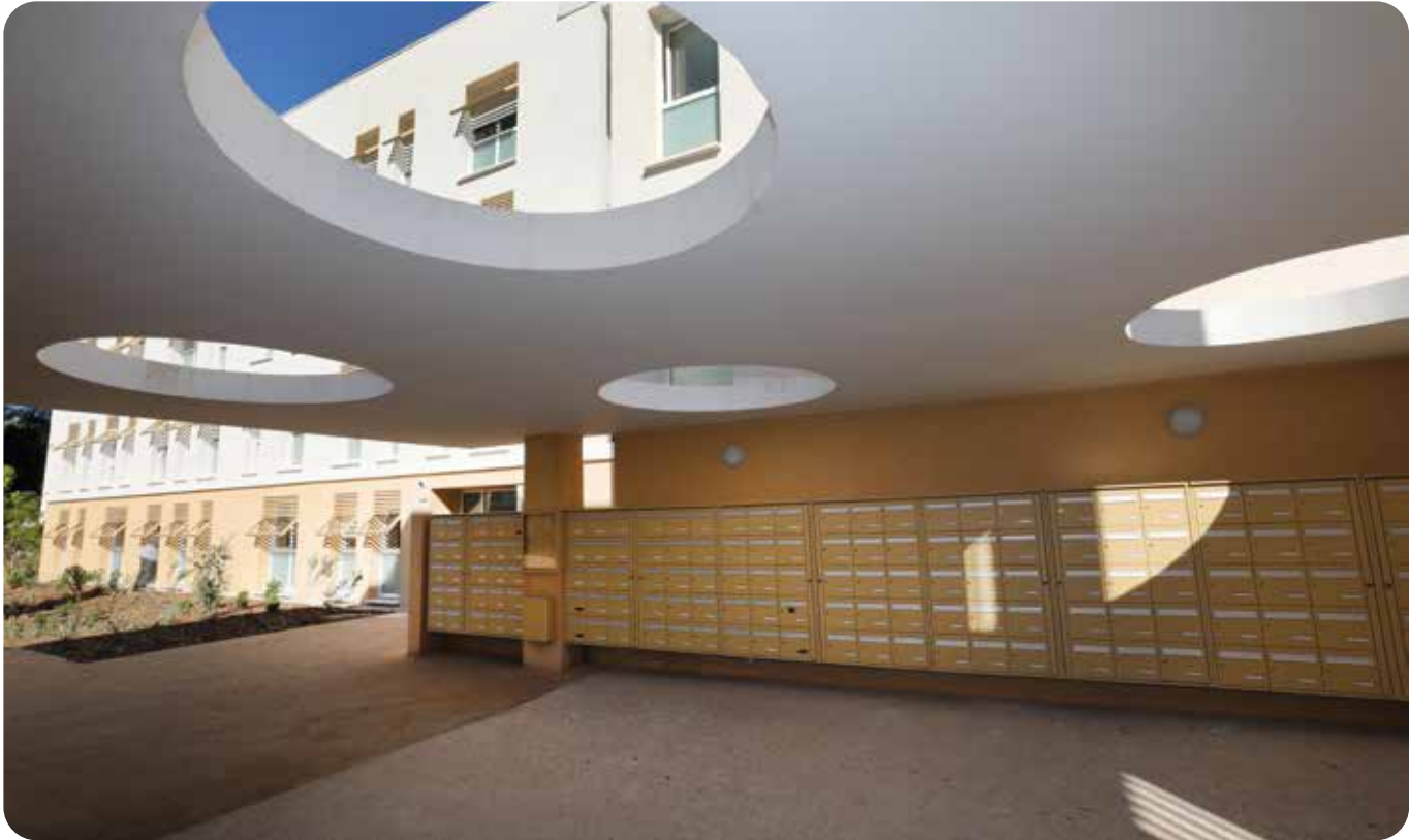
Résidence et pension de famille "Le Peymian" à La Ciotat (13) - 104-25 logements | Architecte : MAP Architectes
