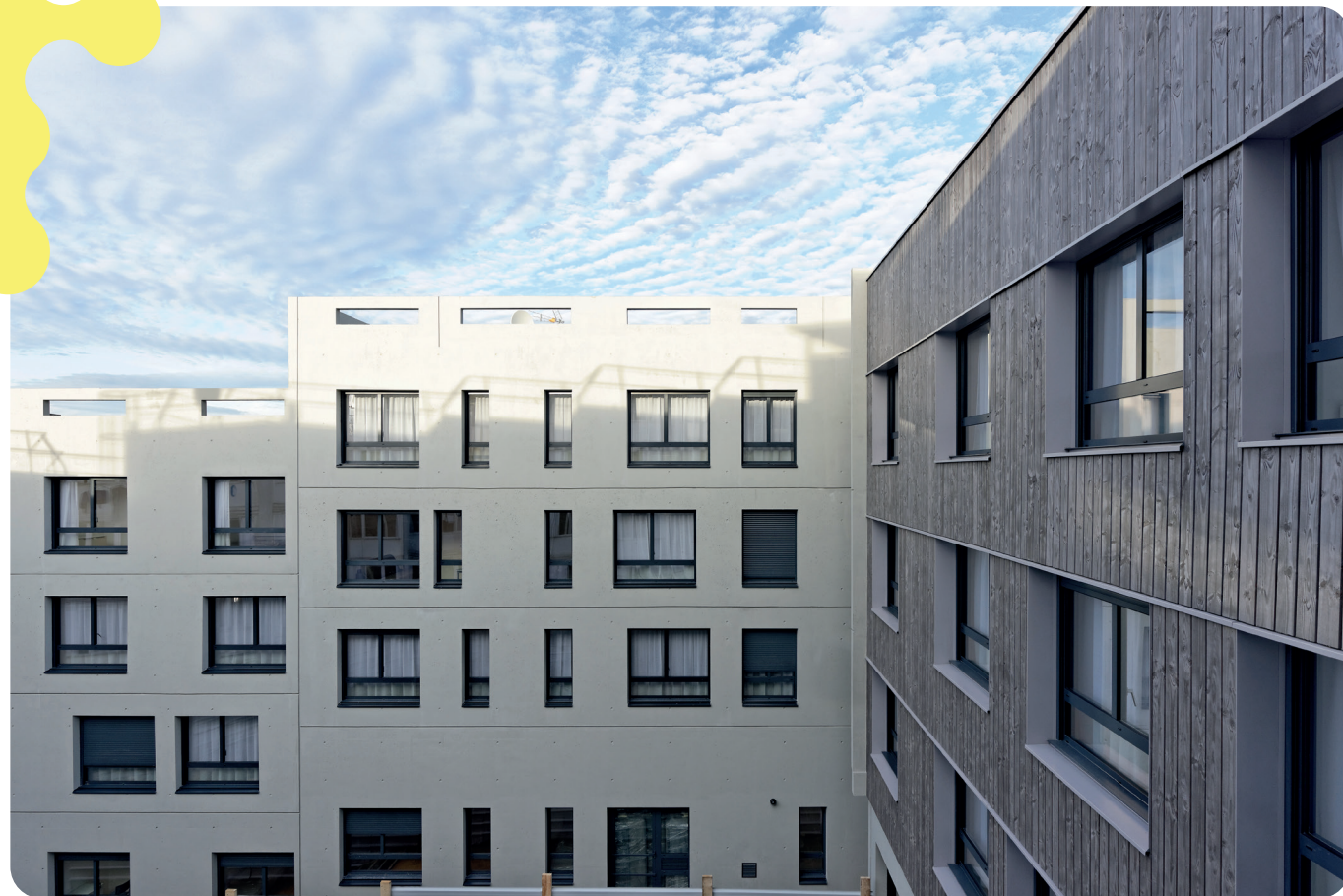
Résidence "Branly" à Montreuil (93) - 160 logements | Architecte : Laurent Niget
