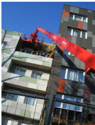
Construction de la résidence « Francis Jammes » à Grenoble. © D.R. Adoma
