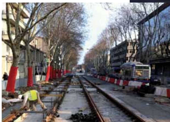
Travaux de la 3 ème ligne de tramway, Cours Gambetta
