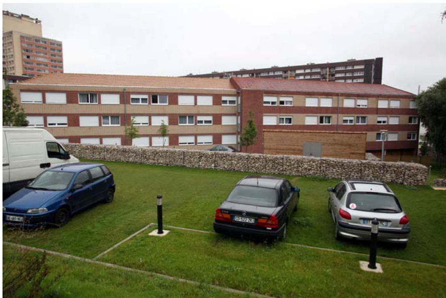
Arrière du bâtiment
